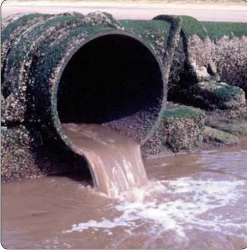
شكل (١١٧) إحدى قنوات الصرف الصحي
