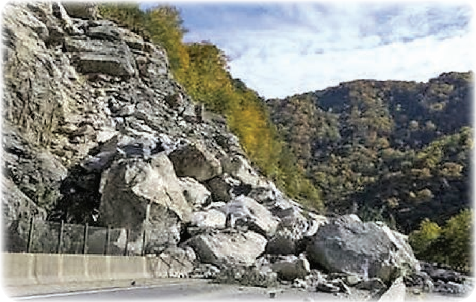
الشكل (3 - 6) أنزلاق الصخور على جوانب الطرق.
